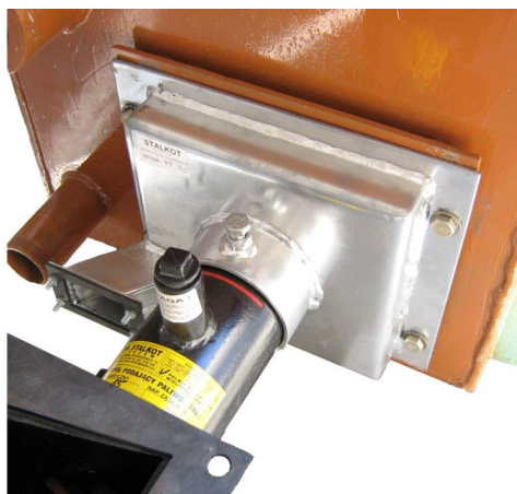
Рисунок 3 – Место установки механизма подачи топлива
