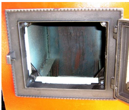
Рисунок 5 – Топочная дверка котла
